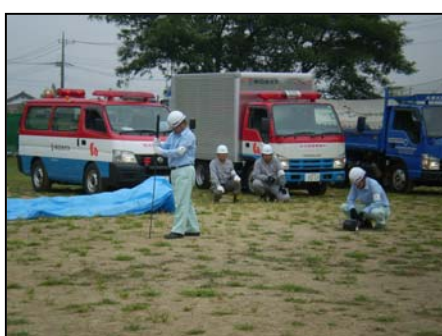
道路に穴をあけて、上ってくるガスの濃度を測定
