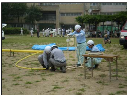
新しいガス管（ポリエチレン管）で入替工事
