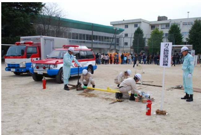
復旧作業（ポリエチレン管に入替）
