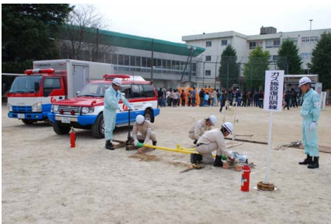
復旧作業（ポリエチレン管に入替）
