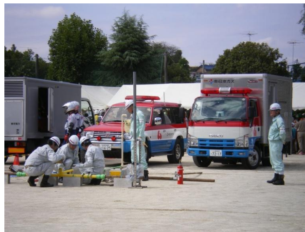
復旧作業（ポリエチレン管へ入替）（写真4）
