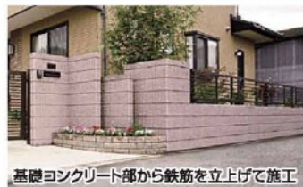
基礎コンクリート部から鉄筋を立上げて施工
